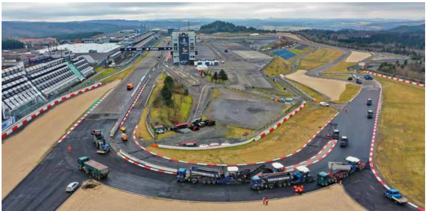
Die Bauarbeiten am Nürburgring aus der Luft. Insgesamt wurden auf der Nordschleife und der Grand-Prix-Strecke 2,5 Kilometer Asphalt erneuert.
