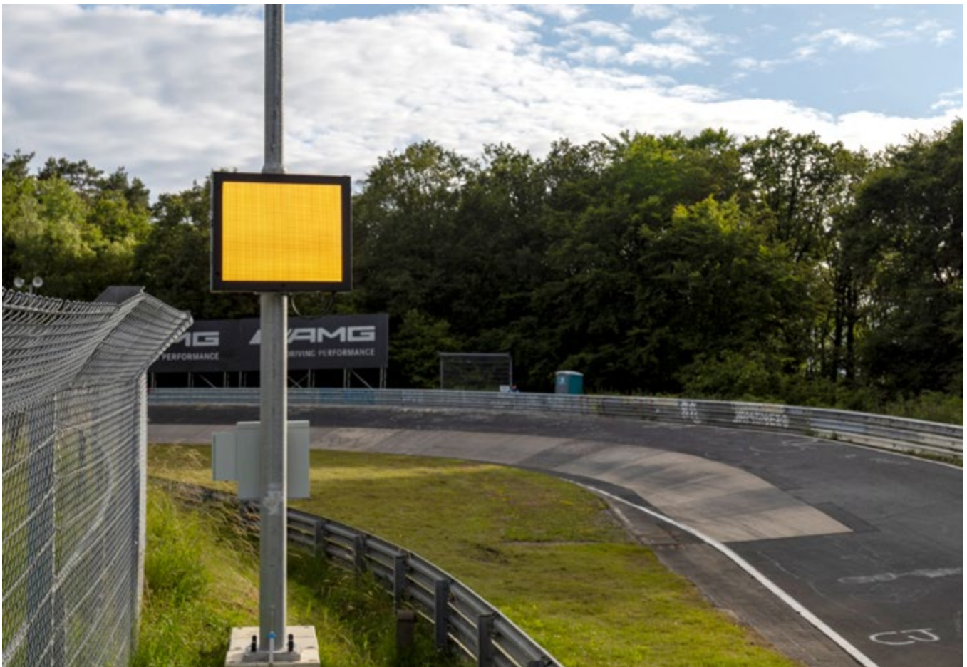
Light Panels sorgen an der Nordschleife für mehr Sicherheit.
